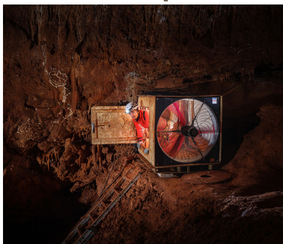
©R.Flament Installation du ventilateur
